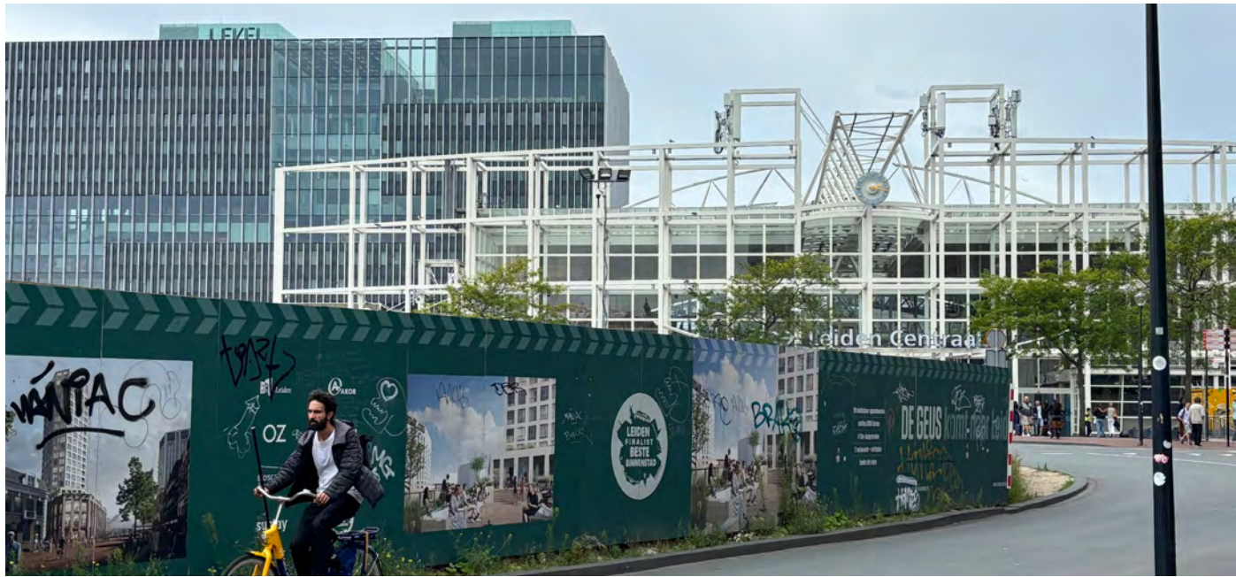
Bouwplaats tegenover het Leiden Centraal, kans voor efficiënte inrichting boven- en ondergronds
